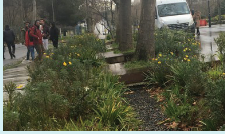
İstanbul Teknik Üniversitesi Ayazağa Kampüsü Yağmur Bahçesi Uygulaması
