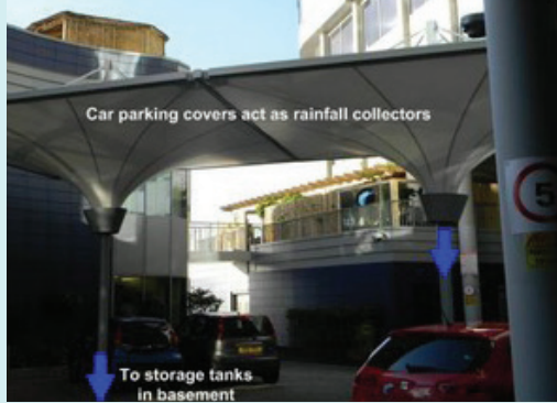
Londra'daki Rafayel Hotel'den Yağış Toplama ve Depolama Sistemine Bir Örnek
